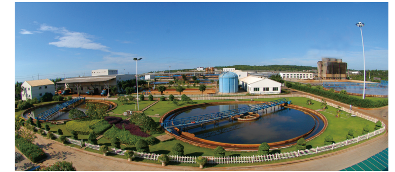
海南金海浆纸污水处理厂 ▲
